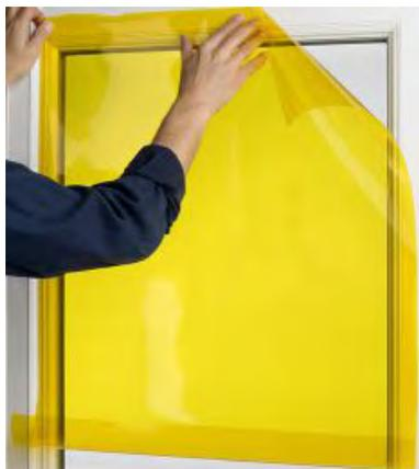
**2** Précoupez le film avec le cutter à un format supérieur de 2 à 3 cm à celui du vitrage.
