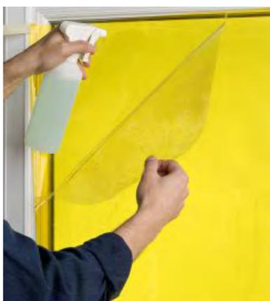
**4** Détachez la pellicule de protection en mouillant abondamment l'adhésif du film à l'eau savonneuse.
