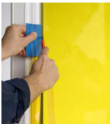
**8** Recoupez le film à un format inférieur de 2 mm à celui du vitrage afin qu'il ne touche pas l'encadrement, puis remarouflez.
